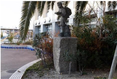
校庭にある二宮金次郎像の台座は石材右側に矢穴の跡がある矢穴石(石切りの際の矢跡が残る石)で、矢穴サイズから築城時の石垣石とみられる。その形から上面が石垣表面とみられる。
